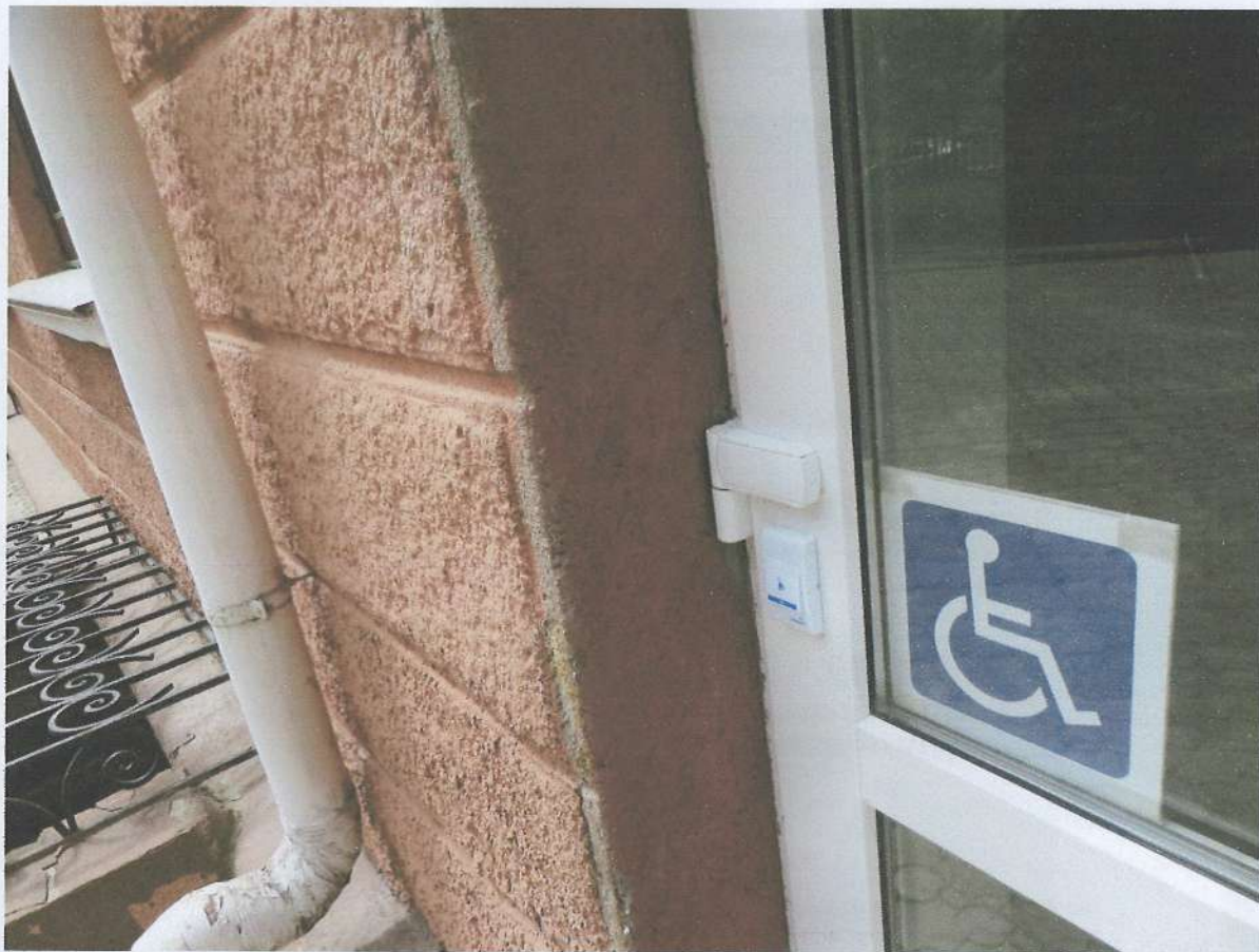
Фото 3.2 Зовнішній вхід до будівлі та шляхи руху для маломобільних груп населення облаштовані "кнопкою дзвінка виклику" персонала та візуальними засобами інформації (піктограмами)
